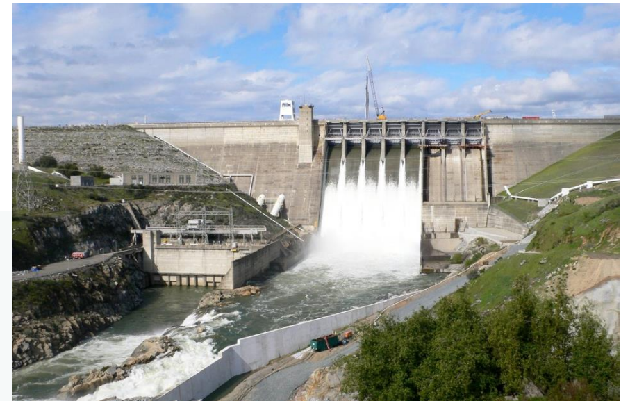
Folsom Reservoir Spilling
